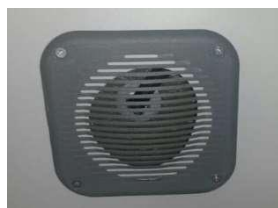
Figura 6. Tapa en el techo para inspección de antenas
